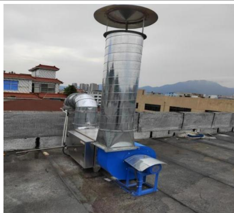
图 4-5 灶台废气静电式油烟处理装置
